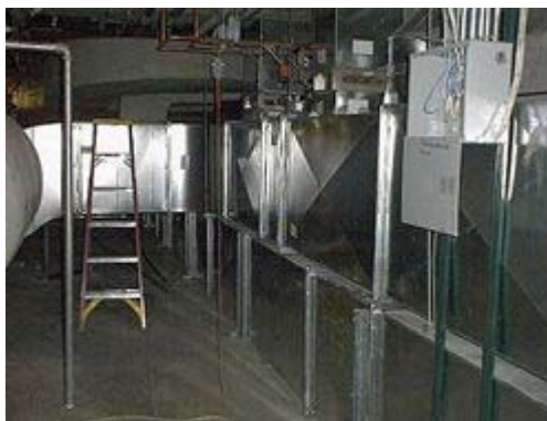
APRIL: HVAC installation.
